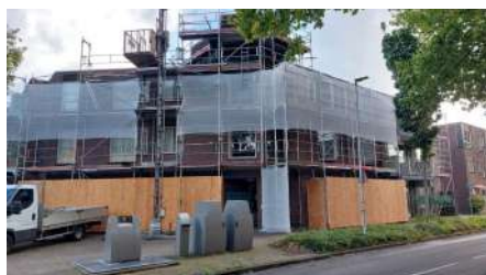
Half september is de renovatie van de jongerenwoningen in Seghwaert van start gegaan.
